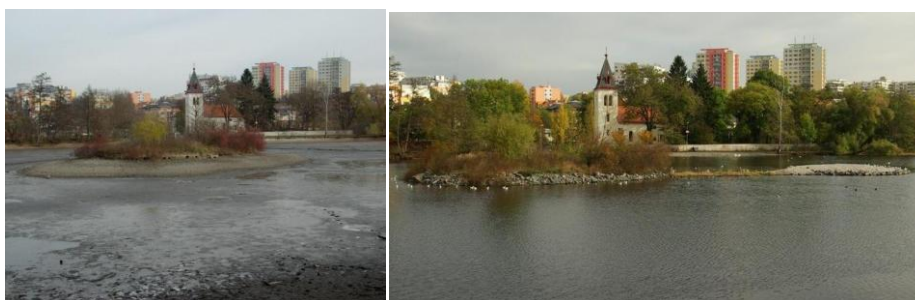
Obr. 11 Hamerský rybník před a po rekonstrukci (Pražská příroda cca 2007 a 2009)
