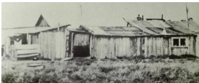
Obr. 26 Nouzová kolonie Slatiny – provizorní dřevěné domky (Kolektiv ONV, 1980)
