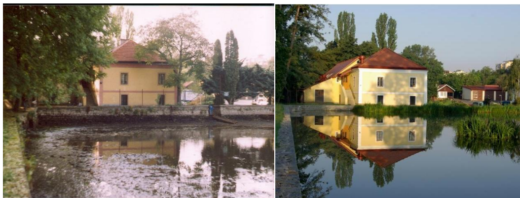
Obr. 14 Práčský rybník před a po rekonstrukci (Pražská příroda, cca 2008)
