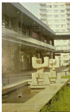
Obr. 30 Obchodní centrum Cíl (cca 1980) – ještě nezastřešené (Pražské kašny, 2016)
