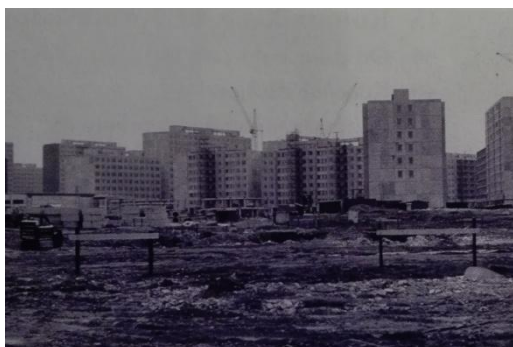
Obr. 34 Stavba Sídliště Chodovec (Bartoň, 2007)
