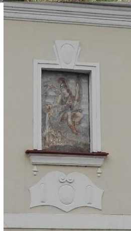
Obr. 45 Budova mlýna a detail malby na zadržném okně (foto autora, 2016)
