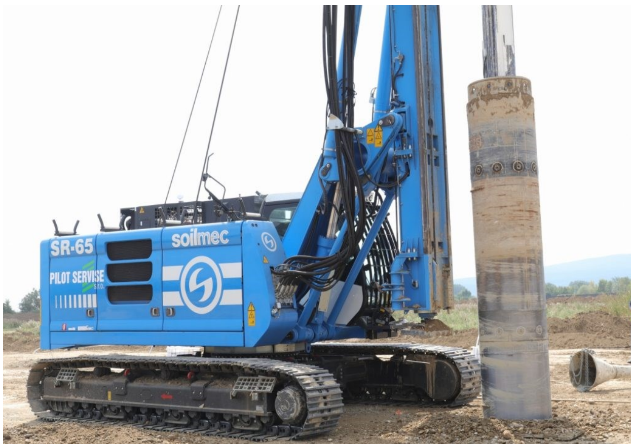
Obrázek 39 - vrtná souprava SOILMEC SR-65
