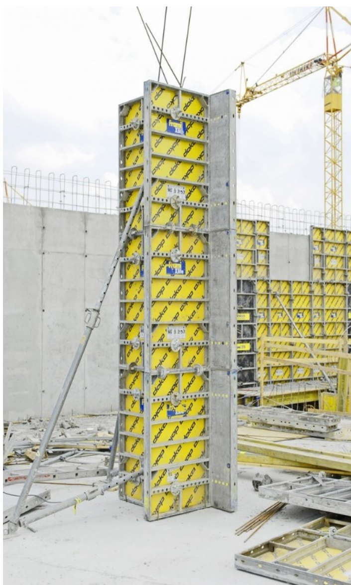
Obrázek 54 - bednění sloupů DOKA
