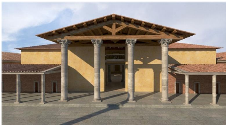
Obr. č. 11 Rekonstrukce Vitruviovy basiliky ve Fano v Itálii (1. stol. př. n. l.), vizualizace. Vazníkový krov s příhradami, které tvoří střední věšadlo a dvě diagonály. Zdroj: https://www.artribune.com/arti-visive/archeologia-arte-antica/2019/08/vitruvio-leonardo-da-vinci-fano/attachment/ricostruzione-virtuale-della-basilica-romana-di-fano-il-cui-progetto-fu-realizzato-da-vitruvio/
