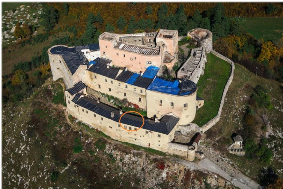
Obr. č. 66 Umístění zkoumané části krovu v kontextu stavby. Zdroj: Paprčka Milan - Slovensko z neba - letecký záber - Krásnohorské Podhradie - hrad Krásna Hôrka (2012)
