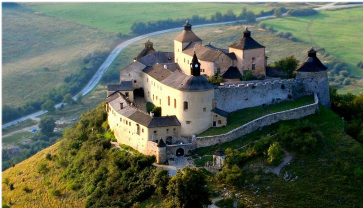
Obr. č. 7 Poslední podoba hradu s šindelovou střechou před vyhořením v r. 2012
