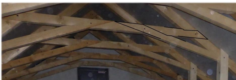
Obr. č. 61 Ukázka rybinového plátování hambalku ke krokvi a pásků k hambalku v krovu hradu Krásná Hôrka (zvýrazněno).
