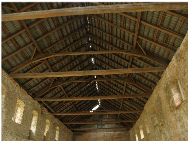
Obr. č. 16 Rozměrný Ránekův krov v již zbouraném objektu v Novém Jimramově. Zdroj: Mirek Navrátil – administrátor facebookové skupiny „Staré krovy“.
