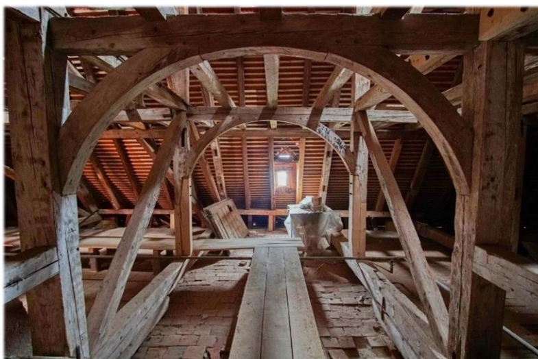
Obr. č. 14 Krov západního křídla zámku v Náměšti nad Oslavou. Krokevní krov se dvěma hambalky podélně vázaný vysokou ležatou stolicí se zakřivenými sloupky a vysokou dvojitou stojatou stolicí upravenou pro podkrovní místnosti [22] . Zdroj: Mirek Navrátil - administrátor facebookové skupiny „Staré krový“.
