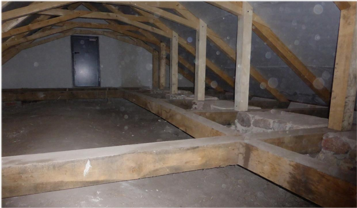
Obr. č. 106 Zazdění pozednice v krovu Krásná Hôrka
