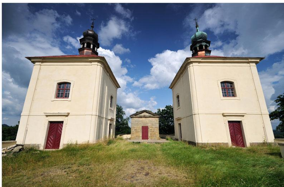
Obrázek 15: Kaple po rekonstrukci
