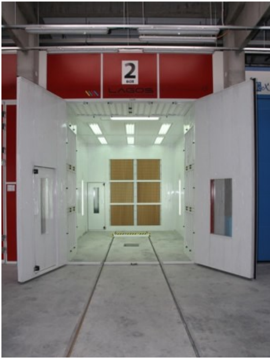
Obr. 3.6 Lakovací kabina polyurethanu LAGOS
