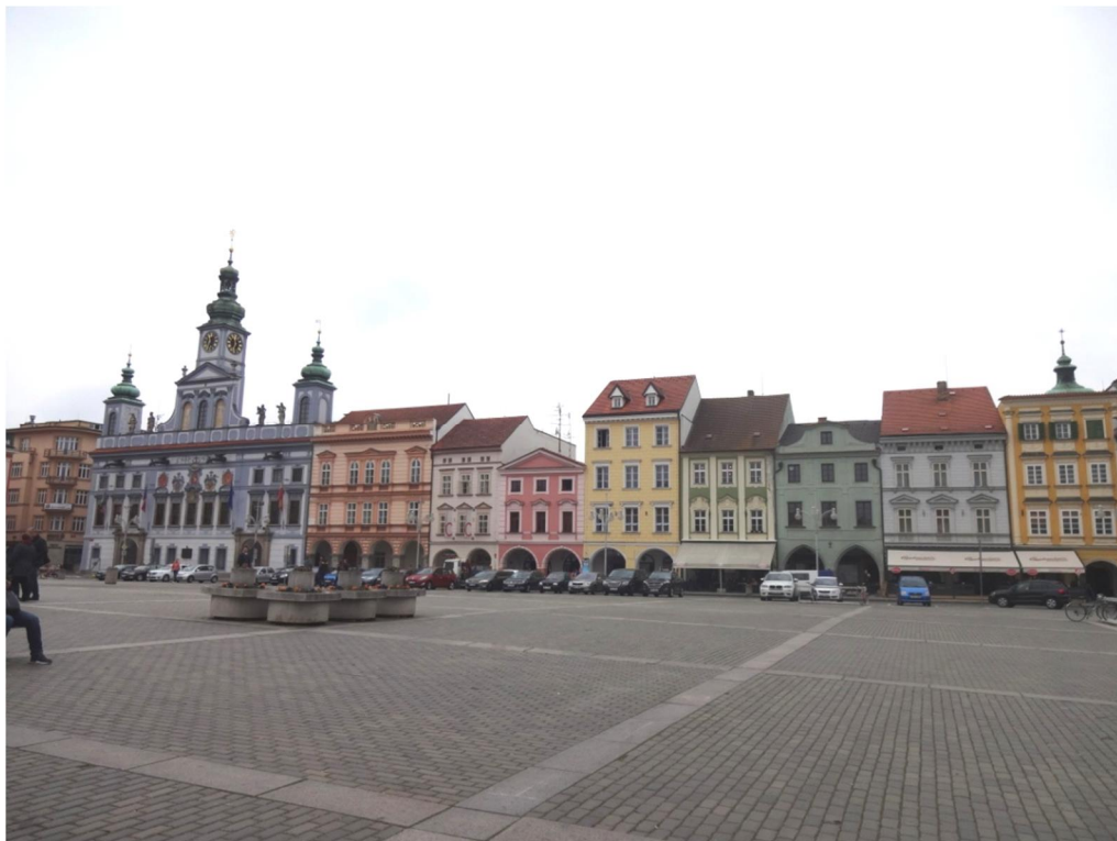
Obr 38: Fotografie bloku budov s radnicí na nám stí P emysla Otakara II.
