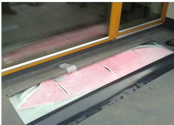
Obr. 1.8 Náhled na degradaci EPS [4]
