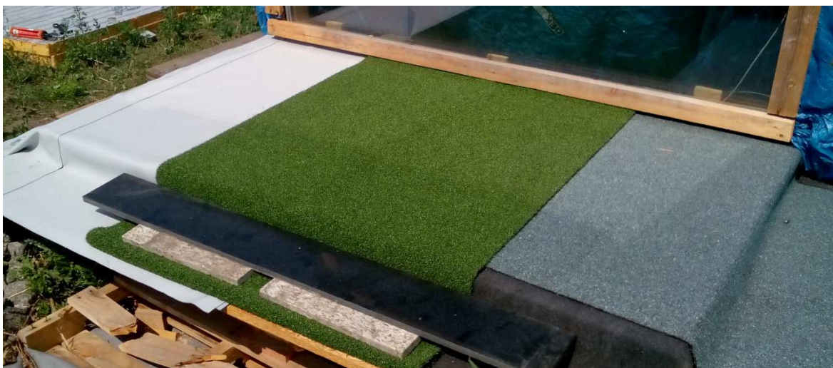
Obr. 8.5 položení travního koberce z umělé hmoty na povlakovou PVC a asfaltovou krytinu
