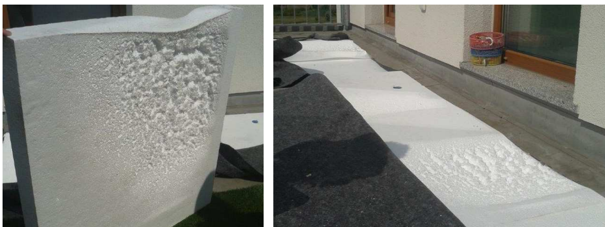
Obr.1.3 Detail degradace EPS desky [4] Obr.1.4 Celková objemové změny EPS[4]
