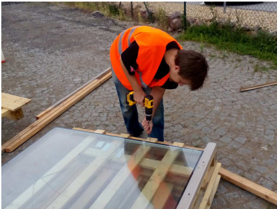
Obr. F.1 Montáž prosklené výplně s izolačním trojsklem 18. června 2015
