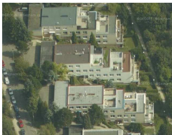
Obr.1.6 Pohled na západní fasádu budovy[70]
