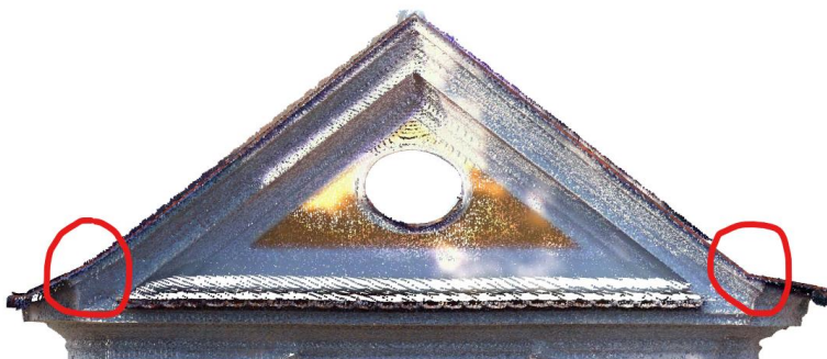
Obr. 70 Zalomení stříšky nad atikovým štítem
