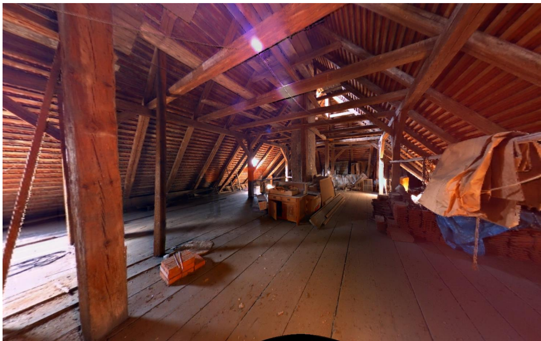
Obr. 64 Pohled na půdní prostory a systém krovu v objektu
