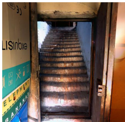
Obr. 42 Schodiště vedoucí na půdu
