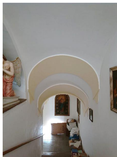
Obr. 5 Skloněné klenby nad schodištěm
