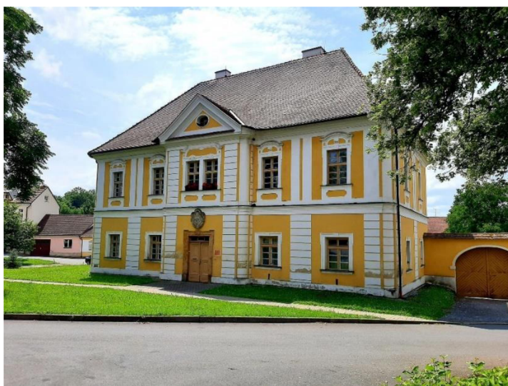
Obr. 4 Pohled na budovu fary z ulice [17]
