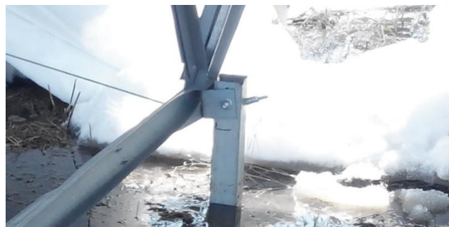
Obr.3.42 Skutočná deformácia v mieste hlavy pilóty
