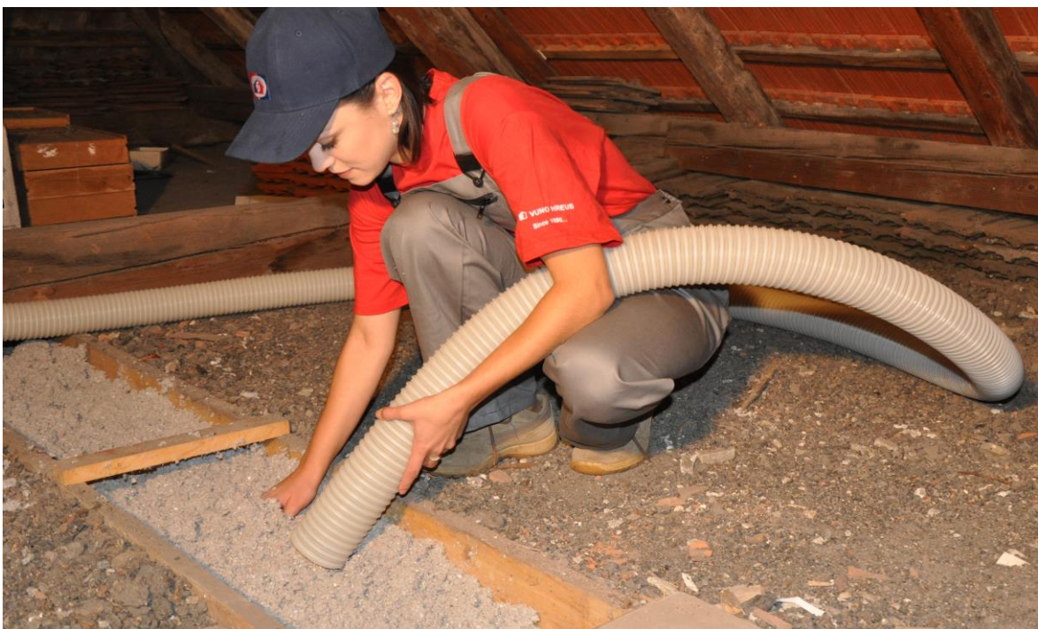
Obr. č.: 6 Foukaná tepelná izolace (zdroj: www.ciur.cz )
