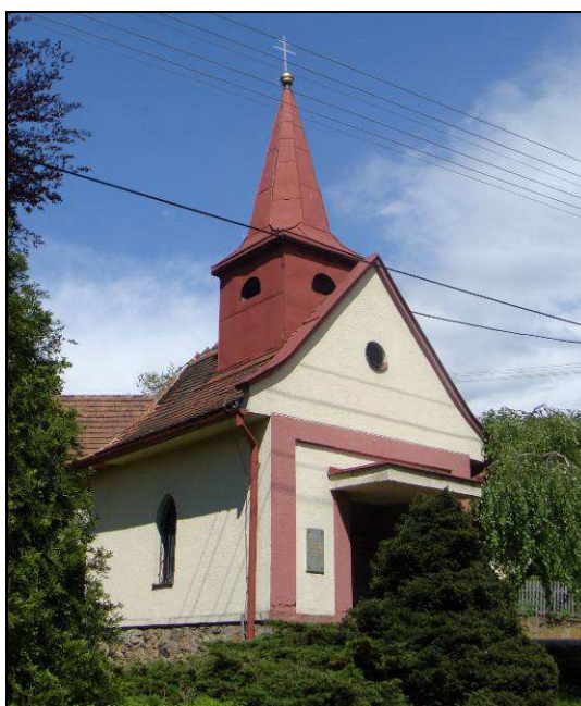
Obr. č. 16: Kaple ve Svárově [zdroj vlastní]
