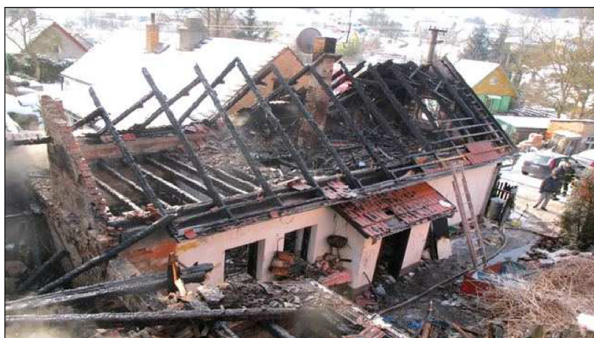
Obr. č. 3: Vyhořelá nemovitost [21]
