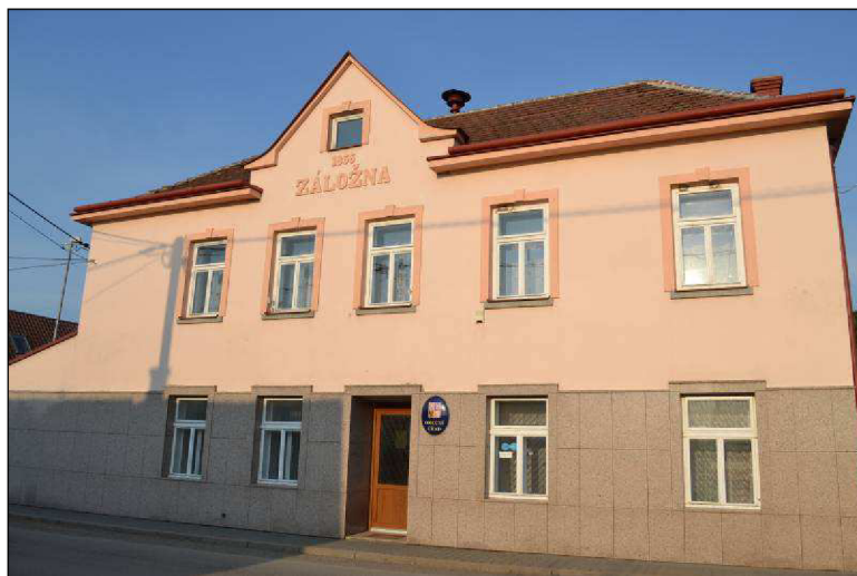
Obr. č. 14: Záložna obce Uhřice [zdroj vlastní]
