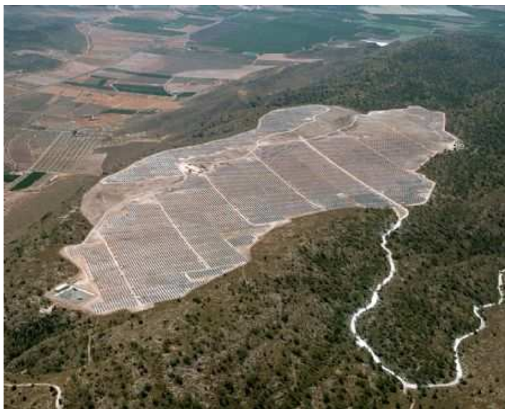
Obr. 1-1 Solární elektrárna s největší instalovanou kapacitou v Jumille v jihovýchodním Španělsku
