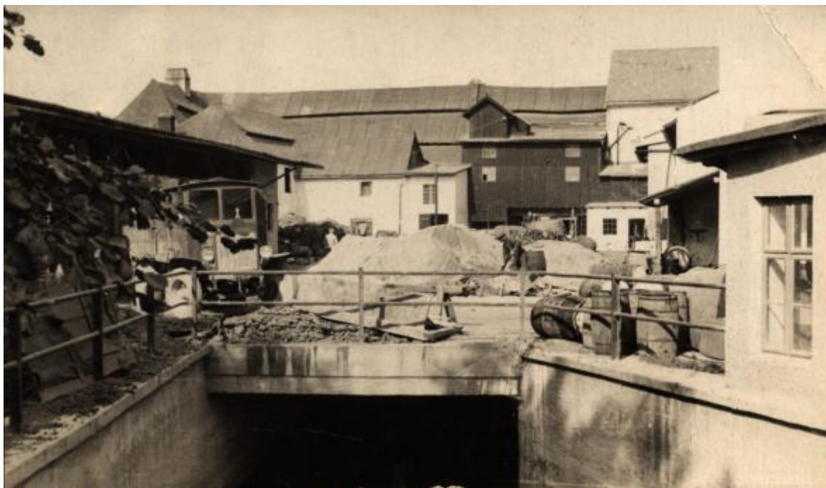
Obrázek č. 48, 49: Litovelská papírna Salomon Grätzer v roce 1920. Obr. č. 49: Litovelská papírna po přestavbě z 30. let (fotografie pochází z roku 1940).(Soukromý archiv: Vítězslav Kollmann)
