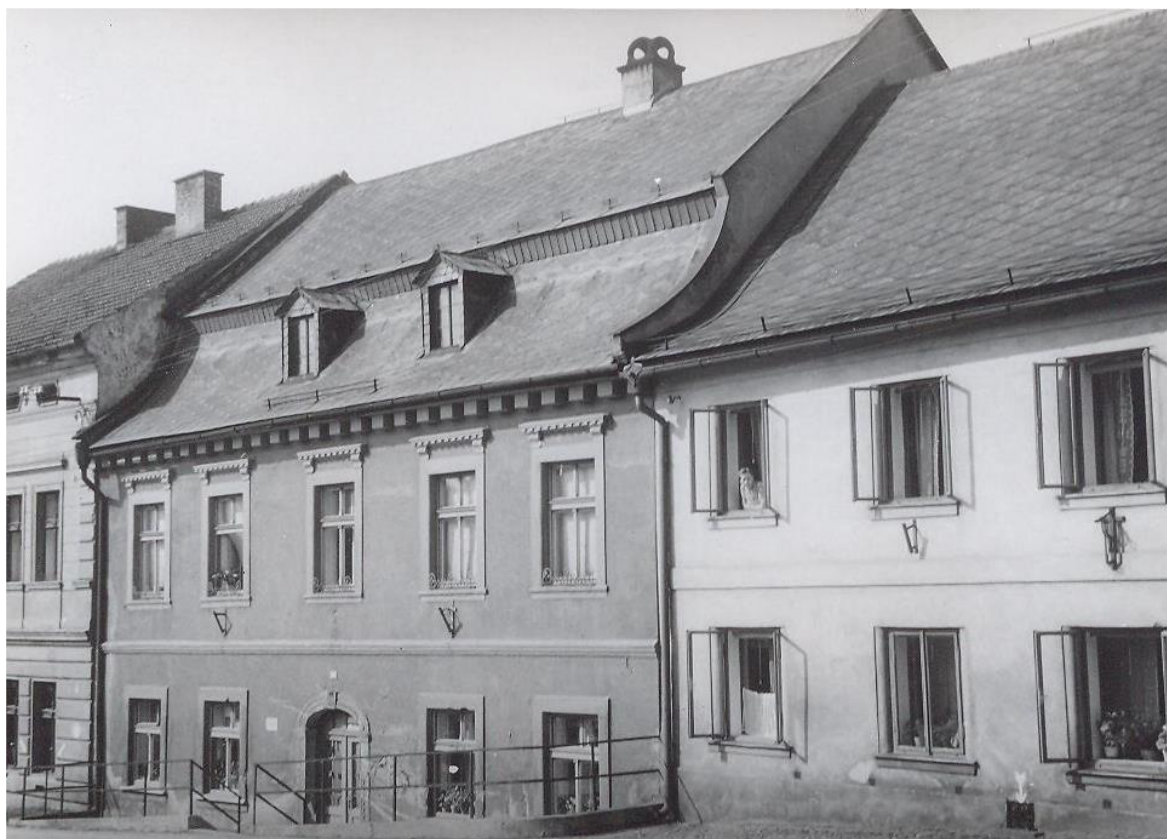
Příloha 4: Objekt v ulici Antonína Dvořáka č. p. 300 před a po výměně střešní krytiny.
