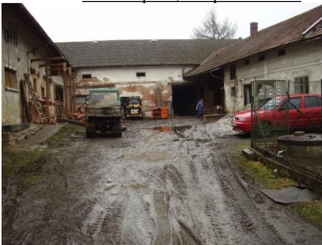
Obrázek 8 - Statek č. p. 83, stav před realizací
