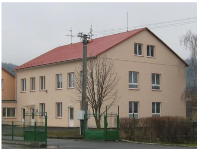
Obrázek 5 - Zateplení III. MŠ v Novém Malíně
