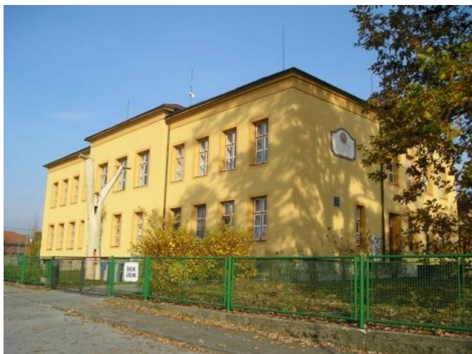
Obrázek 12 - Zateplení budovy ZŠ v Novém Malíně
