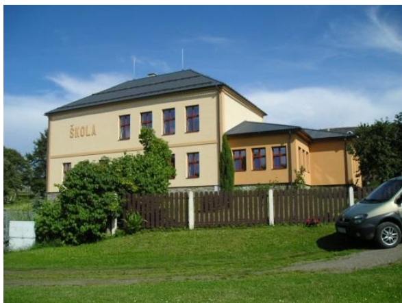
Obrázek 11 - Základní škola a školní družina Mladoňov po realizaci
