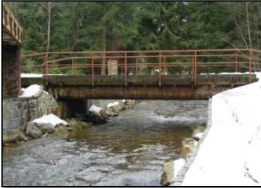
Foto č. 1: Skutečnost – dřevěný mostek (Autor, 2013)
