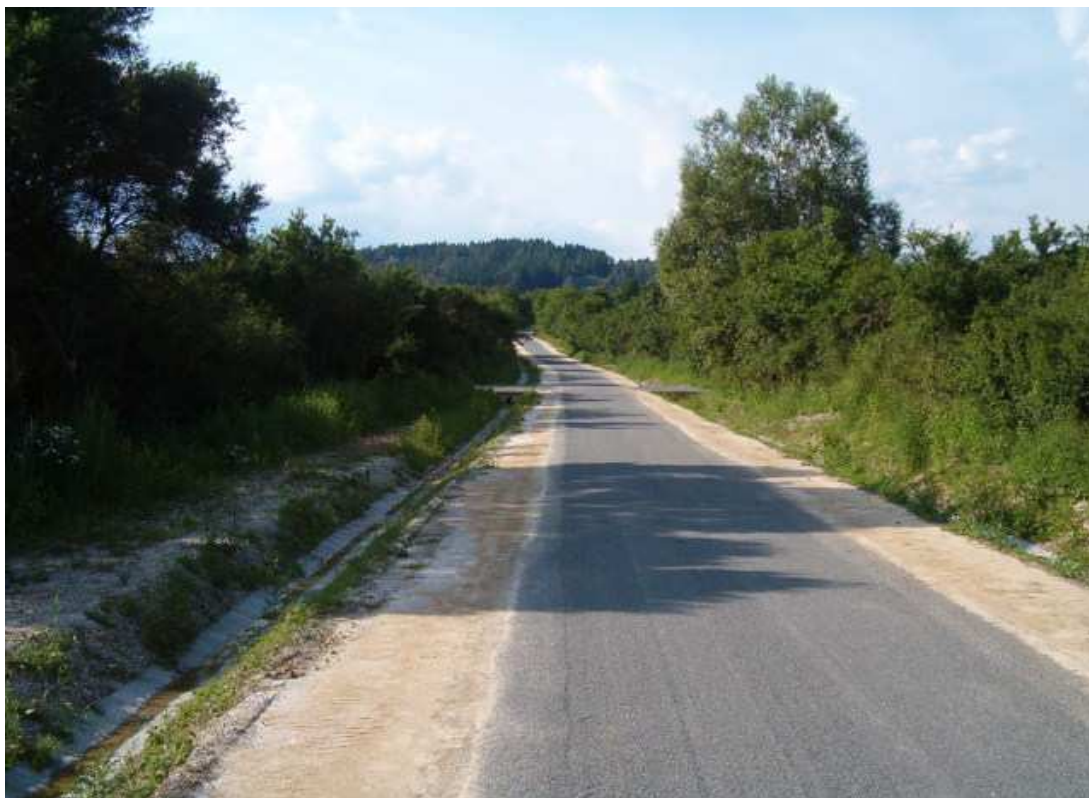
Foto č. 6: Hlavní polní cesta C3 – „Na Borek“
