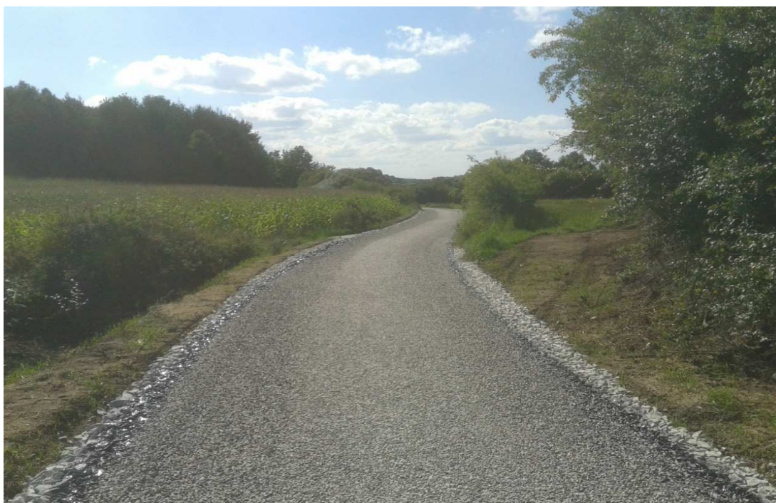
Foto č. 9: Polní cesta C2 „Pod Jívou“ – po realizaci
