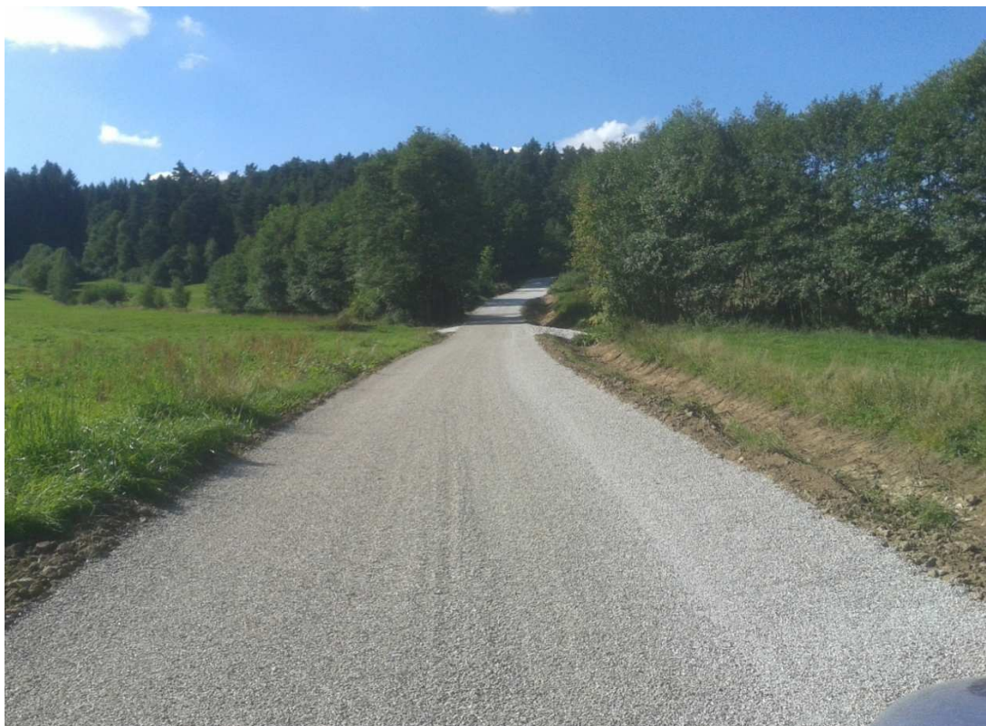
Foto č. 5: Rekonstrukce stávající polní cesty N1 – „Pod Hory“
