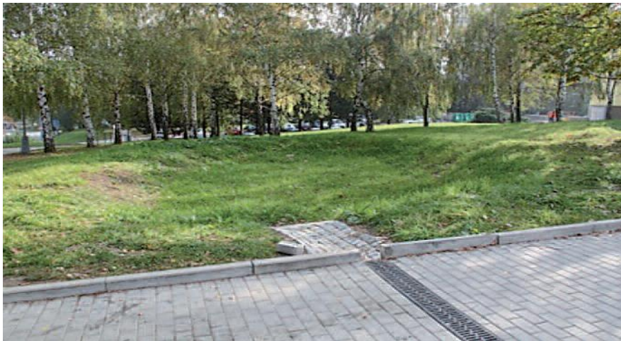
Obrázek 16: Suchý poldr Brno - Kohutovice s řízeným odtokem do kanalizace
