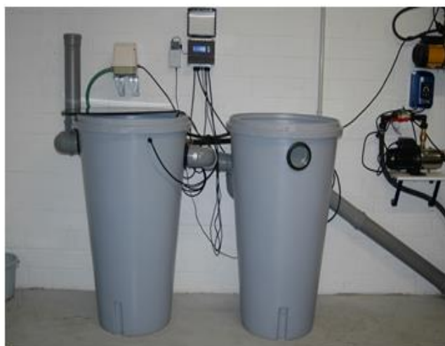
Obrázek 28 : Domovní ČOV pro šedé vody a membránový filtr
