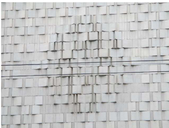
Obr. 3. Detail obchodního domu Don, foto: Barbora Přibyllová
