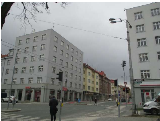
Obr. 17. Věžové domy na Ulrichově náměstí – pohled směrem k Labi
