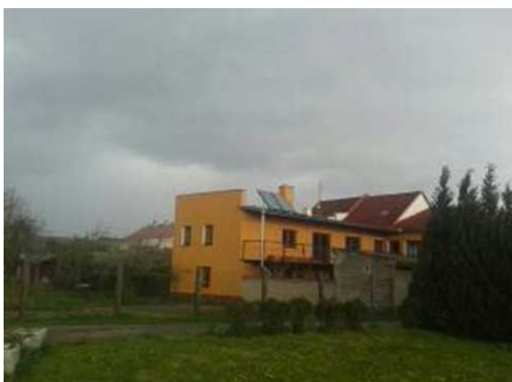
Obr. č. 48 a: Soustava kolektorů pultové střechy (foto Rosskohl).
