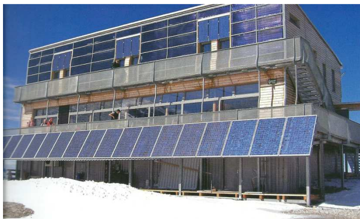
Obr. č. 8: Horská chata Schiestlhaus v rakouských Alpách – typický END se systémy aktivně využívající sluneční energii (4, s. 17).
