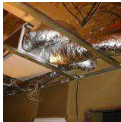
Obr. č. 51 b: Větrací jednotka pro dva apartmány (36).
