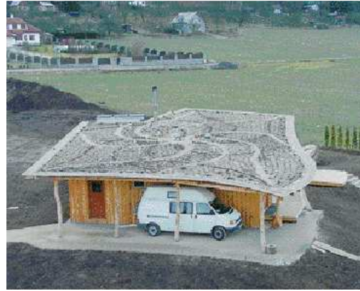
Obr. č. 52b: Zelená střecha přesahy (21, s. 33)
