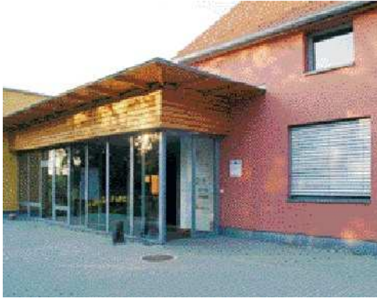
Obr. č. 49 c: Vstupní hala Centra (21, s. 48).
