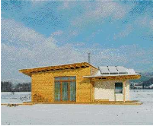
Obr. č. 52a: Do střechy integrovaný solární kolektor (21, s. 33).
