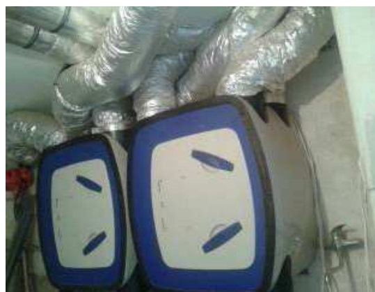
Obr. č. 47 b: Hadicemi Sonoflex napojené jednotky nuceného větrání (foto Rosskohl).
