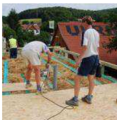
Obr. č. 50 a: Izolace zdi slámou (21, s. 51). Obr. č. 50 b: Izolace ploché střeše slámou (36).
