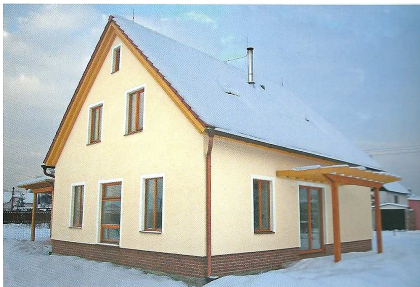
Obr. č. 10: Rodinný NED v Černošicích (ČR) - tradiční architektonická forma se sedlovou střechou s důrazem na minimalizaci tepelných ztrát, kde prosklené plochy tvoří malou část fasád (4, s. 44).
