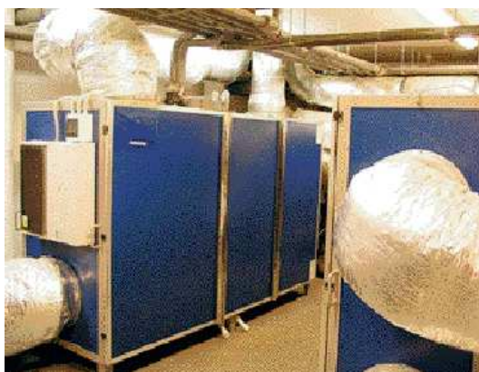
Obr. č. 51: Centrální větrací jednotky (21, s. 49).
