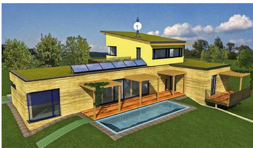
Obr. č. 16: Okna v Domě Snů stíněná přesazenou střechou a slunolamy (14).
