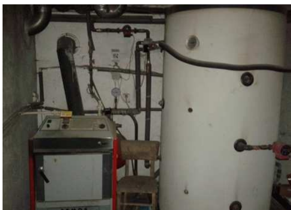
Obr. č. 46 a: Kotel na dřevo a akumulční nádrž (foto Rosskohl).
