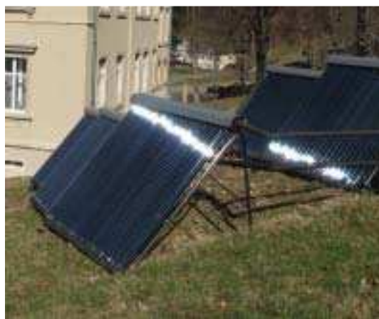
Obr. č. 35: Vakuové trubčové kolektory se vyznačují velkými výnosy i při různém sklonu a natočení. Zejména v přechodném období zabezpečují oproti plochým kolektorům větší zisky (28, s. 3).
