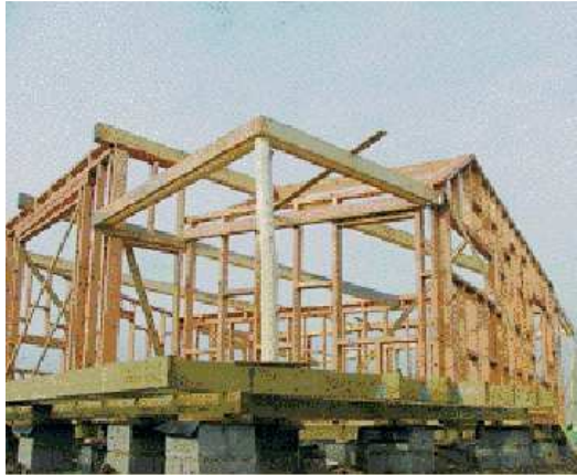
Obr. č. 53 a: Základové sloupky a patky domu (21, s. 32).
