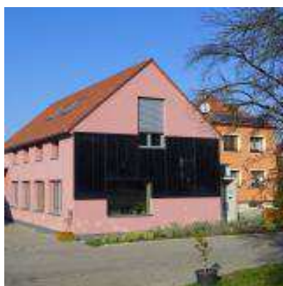
Obr. č. 49 a: Seminární část Centra s velkoplošným fasádním kolektorem (35).
