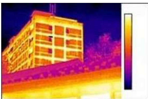
Obr. č. 21a: Termogram s nezatepleným objektem, který je v podstatě jeden velký tepelný most (17. )
