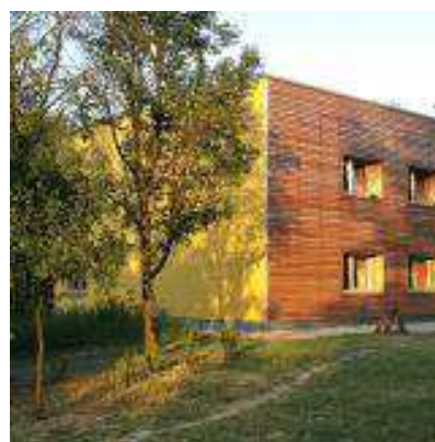
Obr. č. 49 b: Ubytovna Centra (35).
