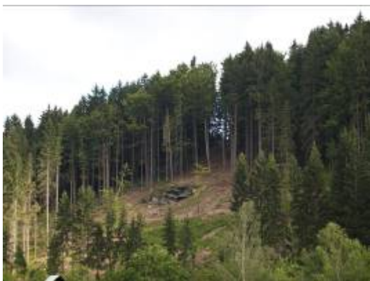
Obr.17.: Kamenná kupa u Dolní Dušnice
