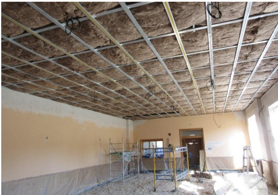
Obrázek č. 10 – Montáž akustického podhledu [24]
