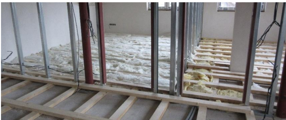
Obrázek č. 16 – Montáž podlah [30]
