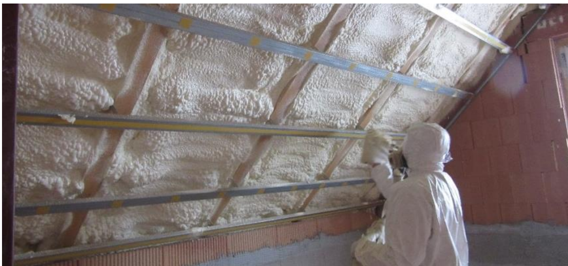
Obrázek č. 13 – Aplikace PUR pěny mezi krokve [27]
