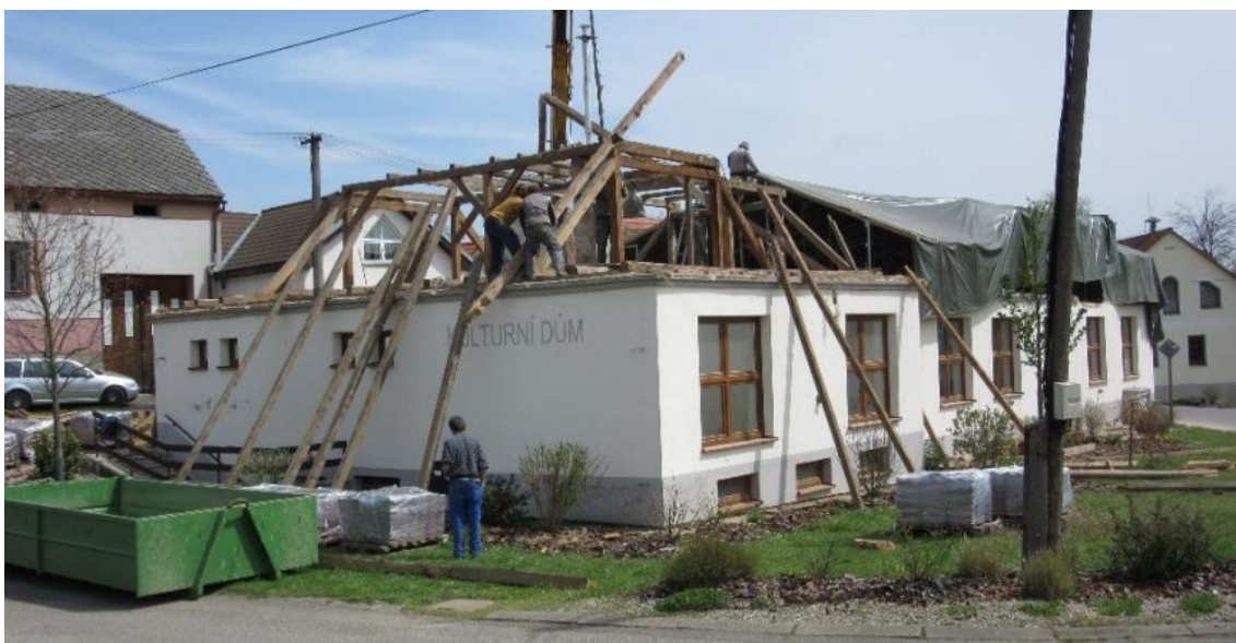
Obrázek č. 7 – Demontáž krovu [21]
