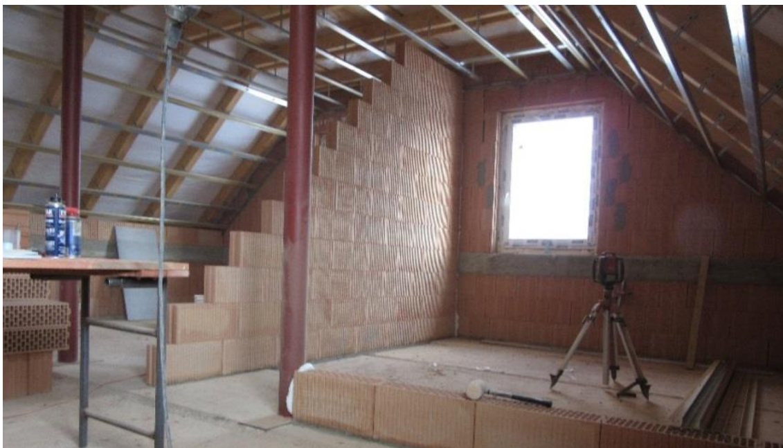
Obrázek č. 12 – Zdění příček [26]
