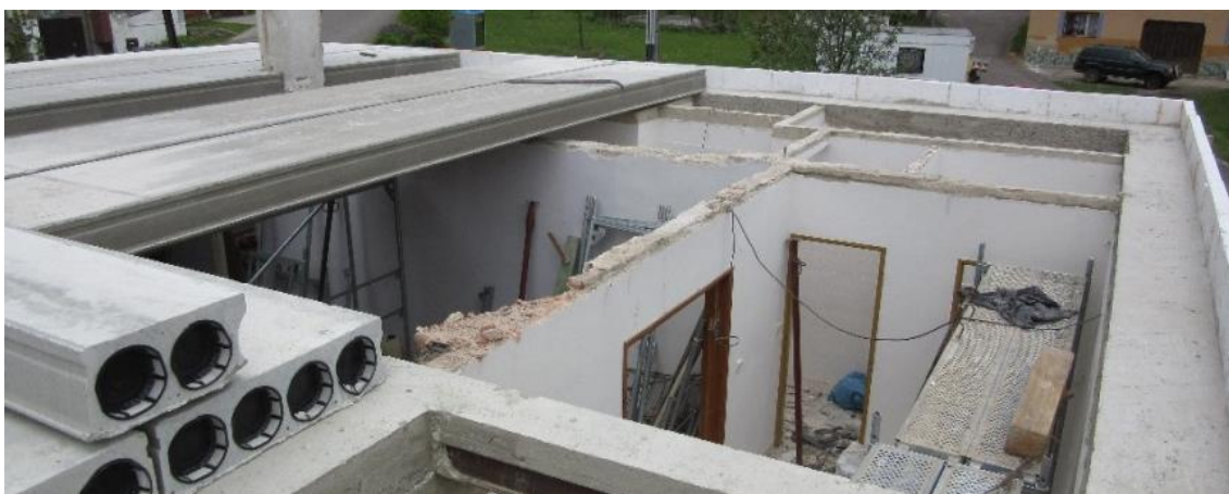
Obrázek č. 9 – Montáž stropních panelů [23]
