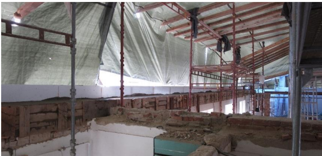
Obrázek č. 8 – Demontáž stropů [22]
