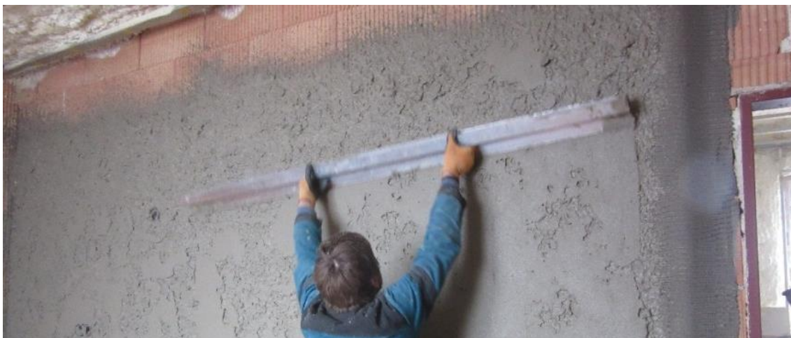
Obrázek č. 15 – Provádění strojních omítek [29]
