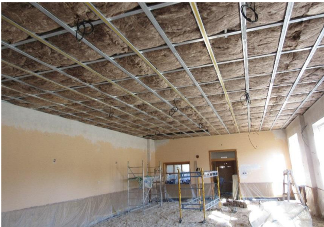
Obrázek č. 10 – Montáž akustického podhledu [24]
