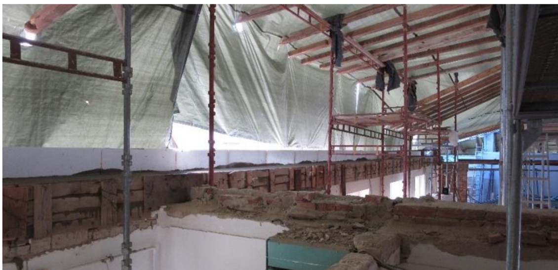
Obrázek č. 8 – Demontáž stropů [22]
