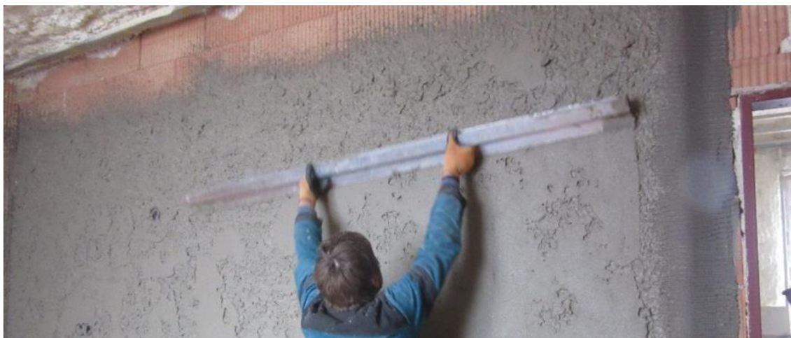
Obrázek č. 15 – Provádění strojních omítek [29]
