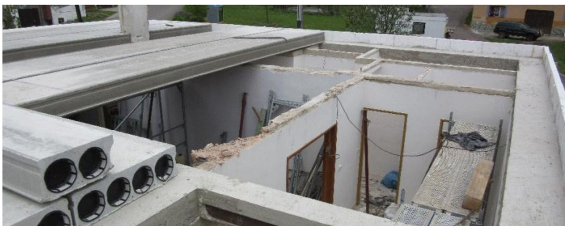
Obrázek č. 9 – Montáž stropních panelů [23]
