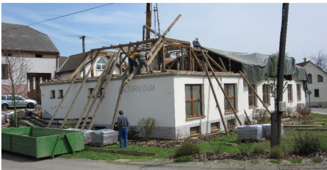
Obrázek č. 7 – Demontáž krovu [21]
