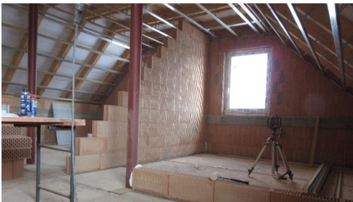
Obrázek č. 12 – Zdění příček [26]
