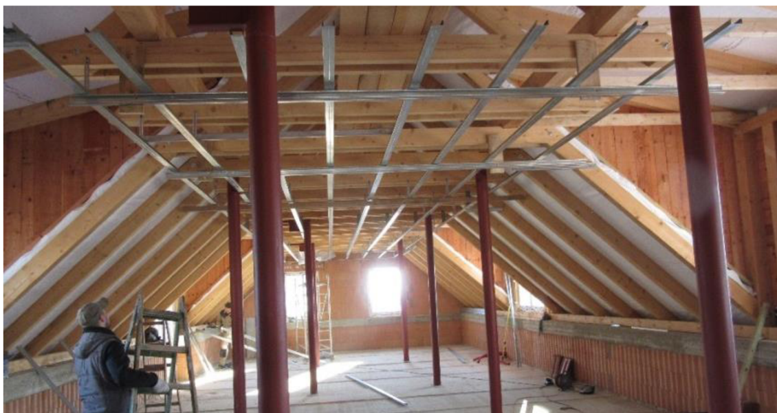
Obrázek č. 11 – Nová střešní konstrukce [25]
