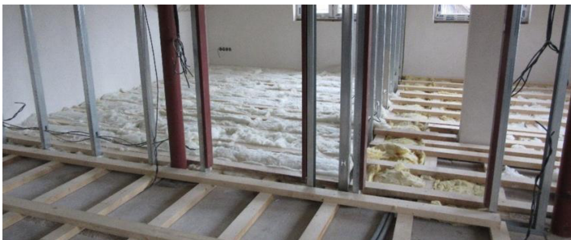
Obrázek č. 16 – Montáž podlah [30]
