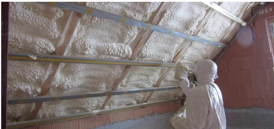
Obrázek č. 13 – Aplikace PUR pěny mezi krokve [27]
