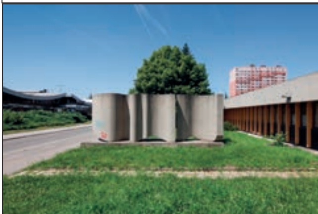
Dekoratívni stěna, Halasovo náměstí, naproti budově TJ Tesla, litý beton, 280×950 cm, 1966–1967, autor Jánuš Kubíček (5. 12. 1921, Nové Hrady u Vysokého Mýta – 21. 5. 1993, Babice nad Svitavou), spolupráce Ing. arch. Viktor Rudiš (9. 6. 1927, Brno), restaurováno 2008 (Ivo Koniček) a 2015, foto: Zdeněk Porcal 2015
