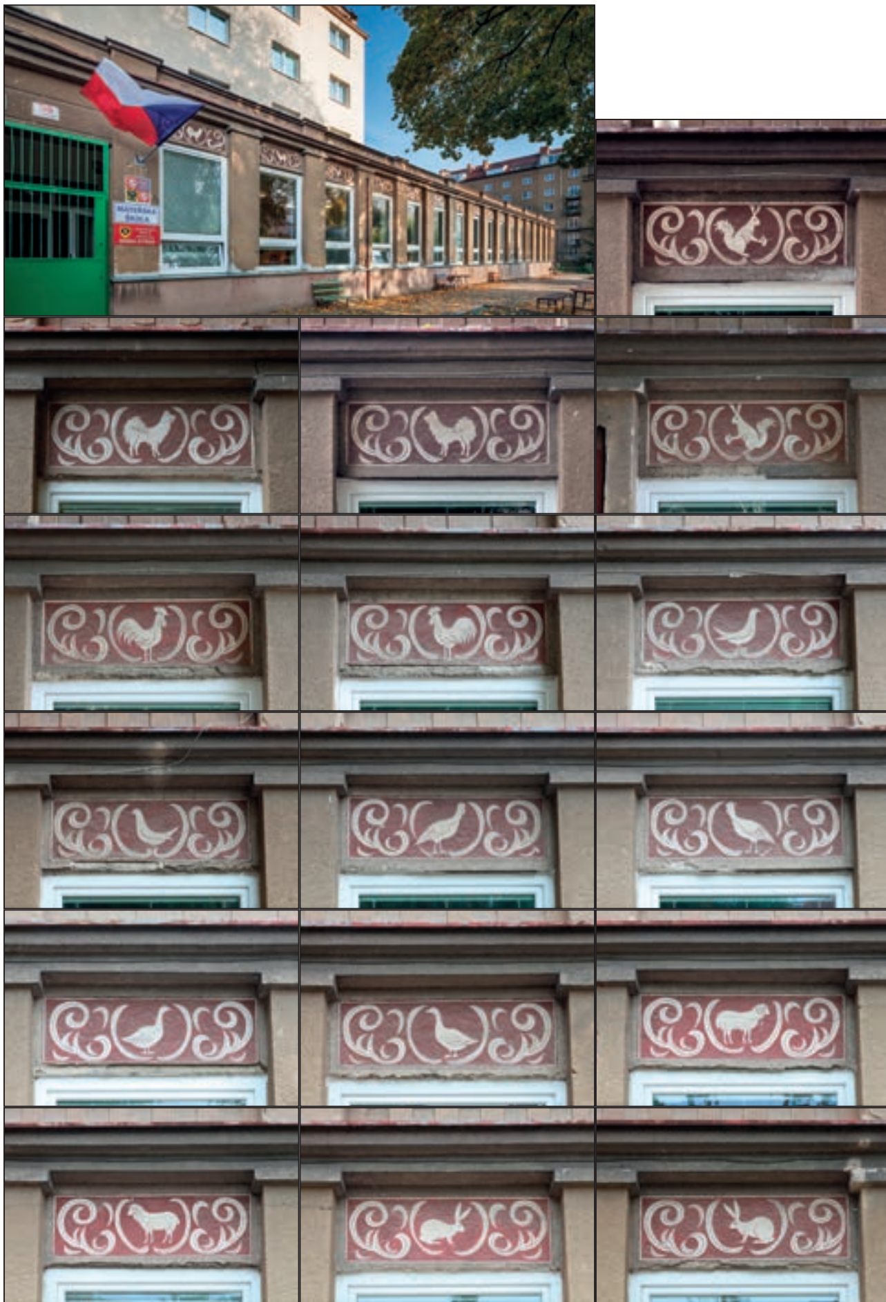
16 sgrafitových výplní se zvířecím motivem na fasádě mateřské školy ve vnitrobloku obytného souboru, Tučkova ulice, cementové sgrafito, 45 × 120 cm, 1956, autor Jan Janča (1. 5. 1907, Uherský Brod – 2. 9. 1992, Brno), foto: Zdeněk Porcal 2014
