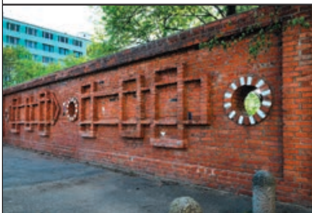
Dekoratívni stěna, Šrámkova ulice, pálená cihla, glazovaná keramika, 280×1480 cm, 1964, autor Bohumír Matal (13. 1. 1922, Brno – 7. 7. 1988, Prudká u Doubravníku), restaurováno 2008 (Jiří Marek), foto: Martin Maleček 2011
