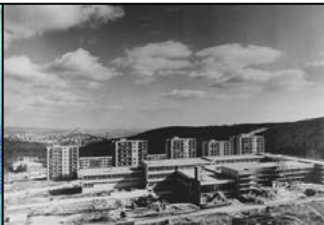
Výstavba sídliště Kohoutovice, 70. léta, foto: AMB, fond U5, sign. XIXb233/1
