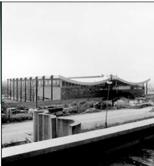
Sportovní hala TJ Tesla ( Viktor Rudiš , spolupráce Dagmar Glosová a Zdeněk Musil , 1973–1982) a dekorativní stěna , Halasovo náměstí, naproti budově TJ Tesla, litý beton, 280×950 cm, 1966–1967, autor Jánuš Kubíček (5. 12. 1921, Nové Hrady u Vysokého Mýta – 21. 5. 1993, Babice nad Svitavou), spolupráce Ing. arch. Viktor Rudiš (9. 6. 1927, Brno), restaurováno 2008 ( Ivo Koníček ) a 2015, foto: Karel Šabata 1984, MmB: fotoarchiv, inv. č. E18.527/23.692
