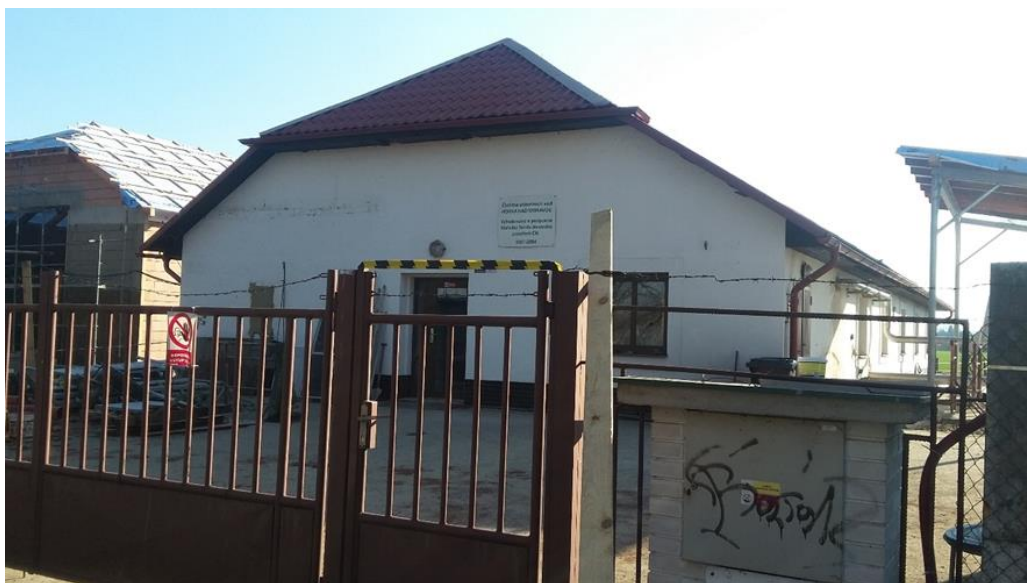
Obrázek 15: ČOV Horka nad Moravou (foto vlastní, 2017)
