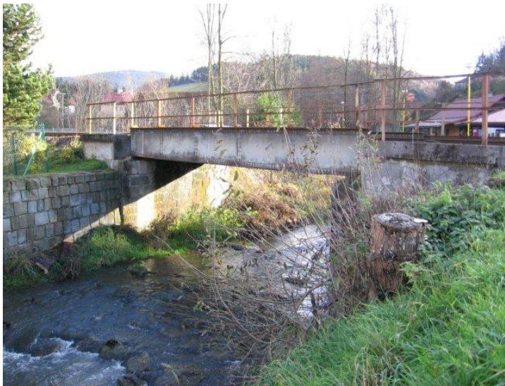
Obr. 9: Železniční most přes Zděchovku (Foto: H. Václavíková, 2013)
