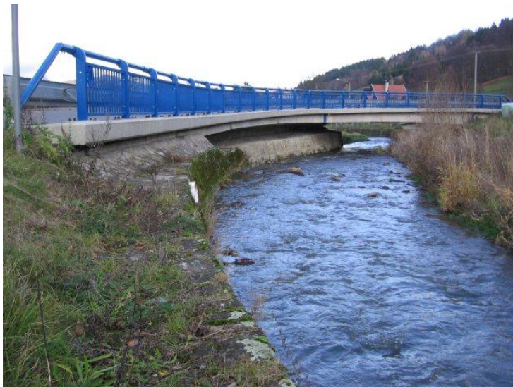
Obr. 10: Opravený most přes Zděchovku směrem na Zděchov (Foto: H. Václavíková, 2013)
