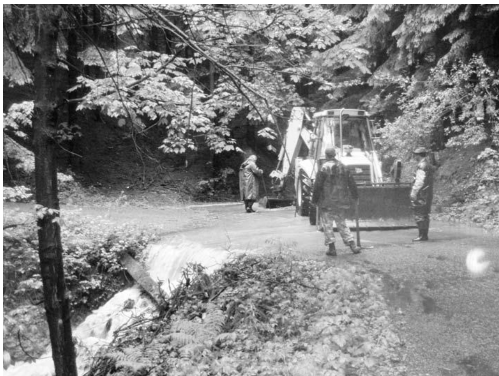
Obr. 43: Oprava propustku v chatové osadě Vlčnov (Zdroj: www.zdechov.cz )
