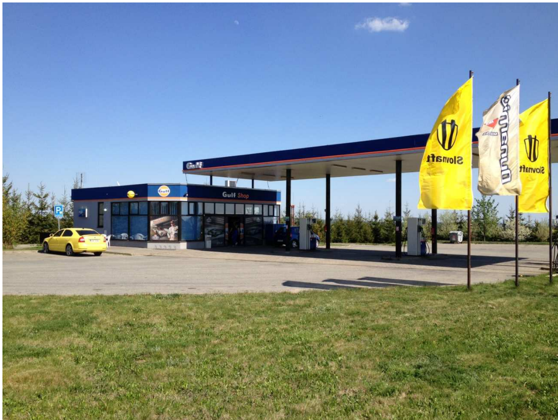
Obrázek 1: Čerpací stanice GULF Valeč
