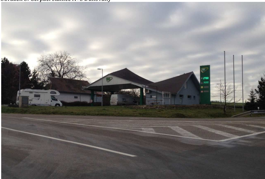
Obrázek 3: Čerpací stanice A+S Dukovany
