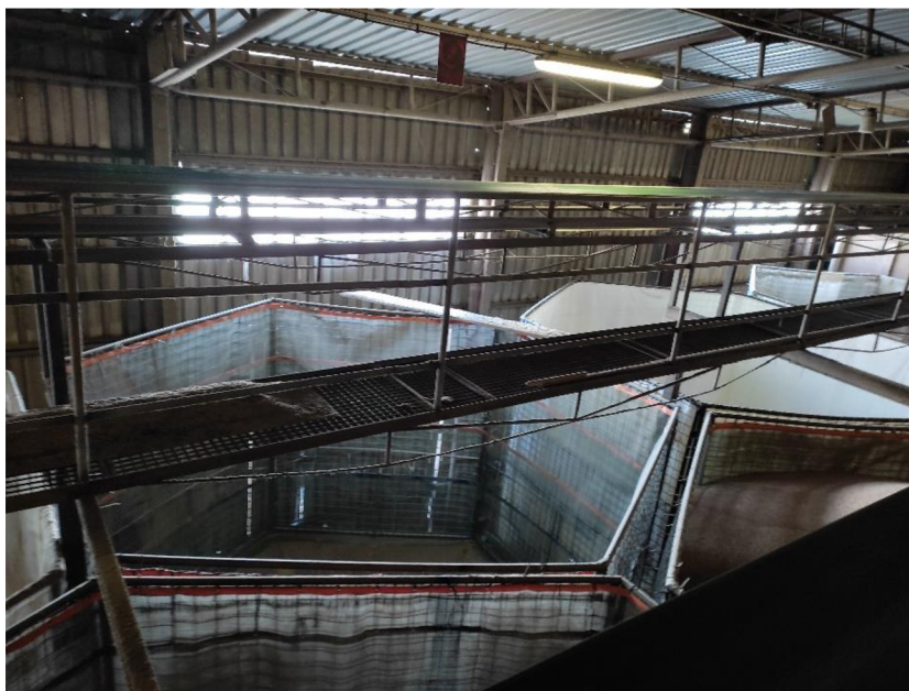
Obrázek 17: Šestiúhelníková sila ve skladu S3 (foto autor)
