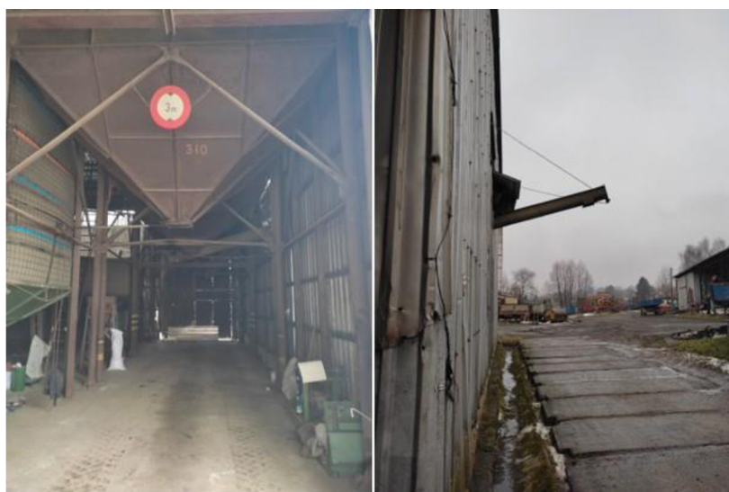
Obrázek 18: (zleva) průjezd budovou, vývod šnekového dopravníku (foto autor)
