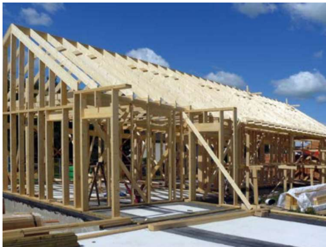
Obrázek 1 – Fošnová konstrukce Two by Four (Zdroj: [2])
