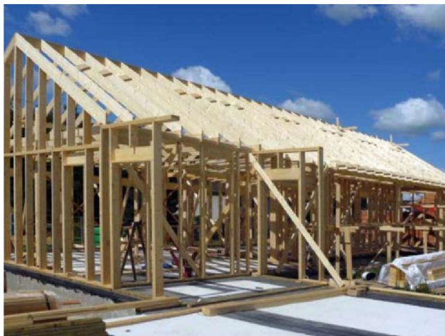
Obrázek 1 – Fošnová konstrukce Two by Four (Zdroj: [2])
