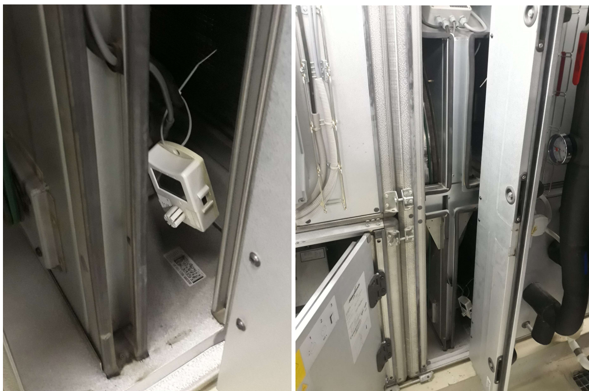
Obrázek 63 – Datalogger Comet umístěný na přívodu v ZZT
