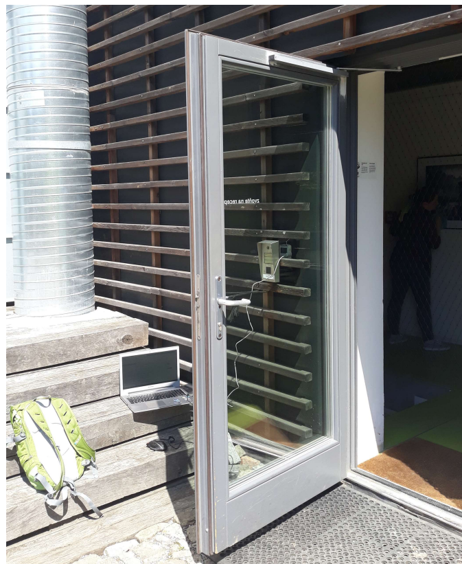
Obrázek 67 – Datalogger Comet umístěný na fasádě za zvonkem v exteriéru
