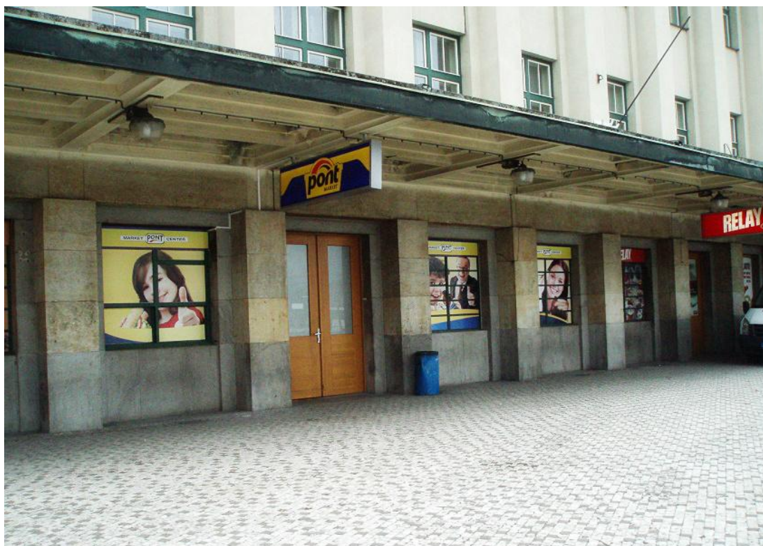
Fotografie 3: Okna budovy nádraží polepená reklamou kazí estetický dojem.
