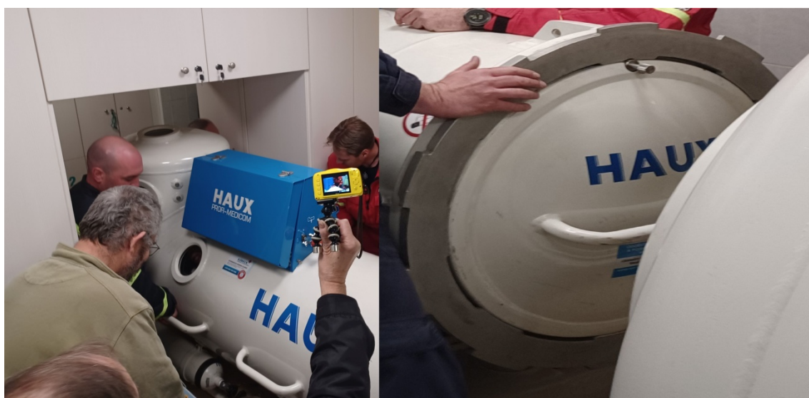
Obrázek 19: Průchod a detail zámku barokomory Haux (zdroj: vlastní)
