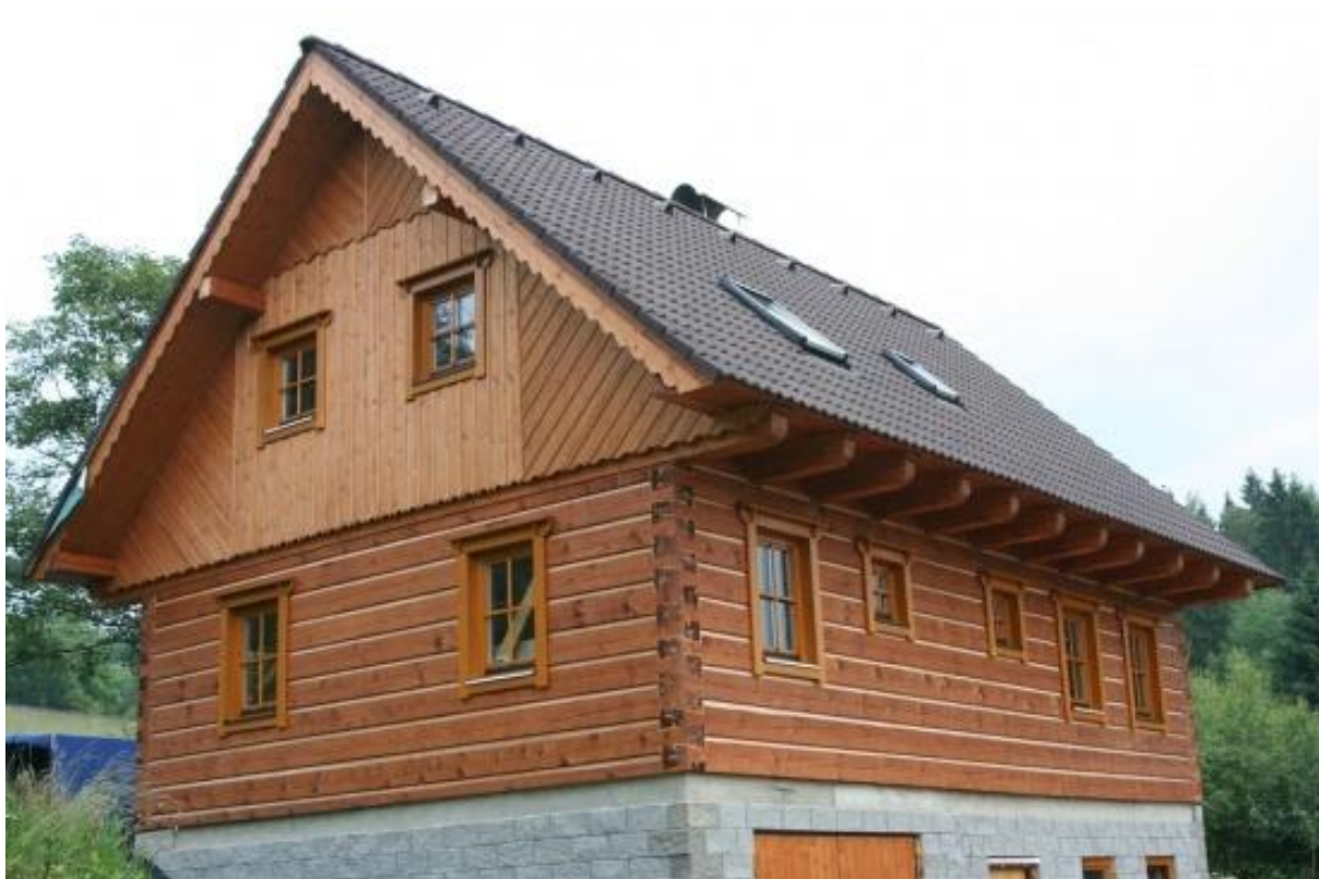
Obrázek 1 - roubená stavba, zdroj: KELÁREK, Jaroslav. Malá roubenka [online]. KELLIWOOD.2012 [cit. 6.4.2016]. dostupné z: http://www.srubyservis.cz/aktuality-historie-a-typy-roubenych-staveb-a-roubenek
