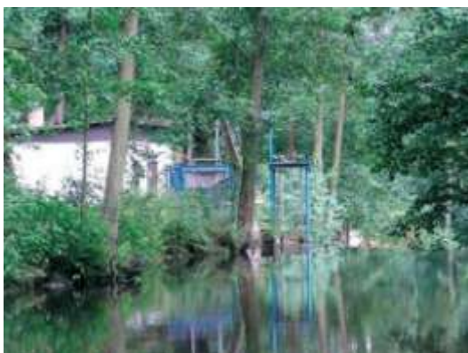
Foto č. 5 - Malá vodní elektrárna na Rolavě s instalovaným výkonem 30 kW
