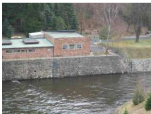
Foto č. 6 – Malá vodní elektrárna Březová s instalovaným výkonem 290 kW
