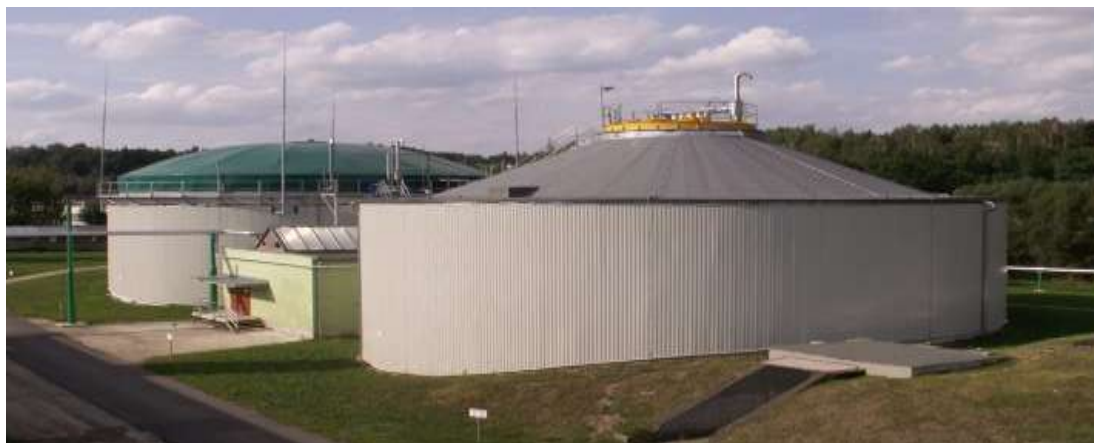
Foto č. 9 – Vyhnívací nádrže pro tvorbu bioplynu v prostorách čističky odpadních vod Karlovy Vary
