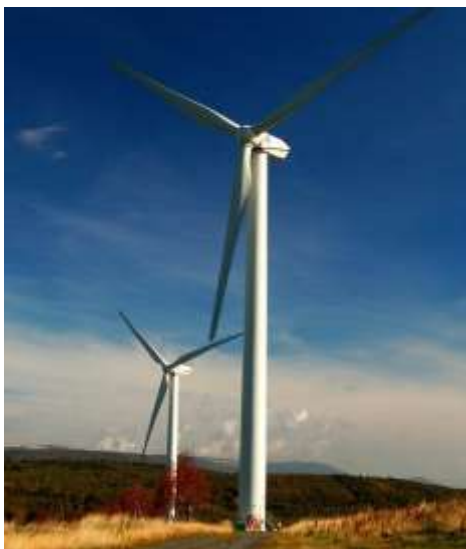
Foto č. 3 – Větrné elektrárny u Vrbice
