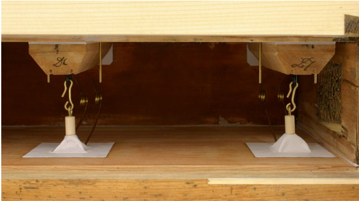
Obr. 6 Pohled do restaurované ventilové komory [3].
