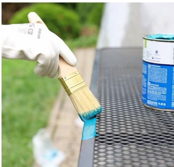
Obr. 30 Nanášení nátěrové hmoty štětcem [23].
