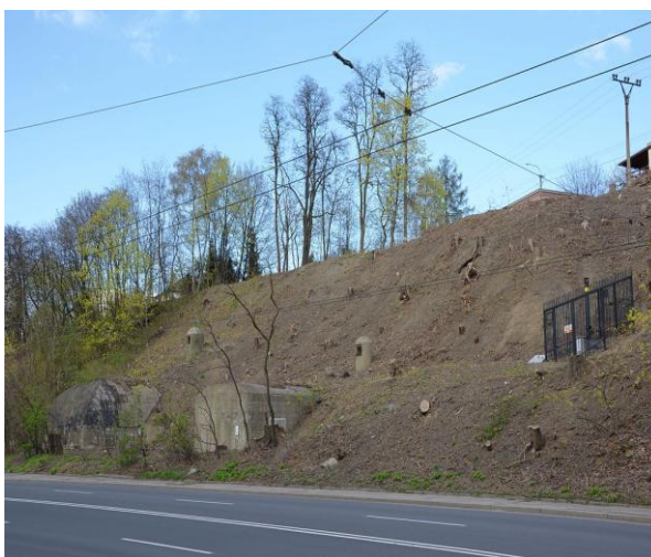
Obrázek 33 - Odkrytá stráž vrchu Jaklovec nad Bohumínskou ulicí ve Slezské Ostravě: vpravo ústí Jaklovecké dědičné štoly, uprostřed ústí štoly sloje Jan ( https://cs.wikipedia.org/wiki/Jaklovecké_doly )
