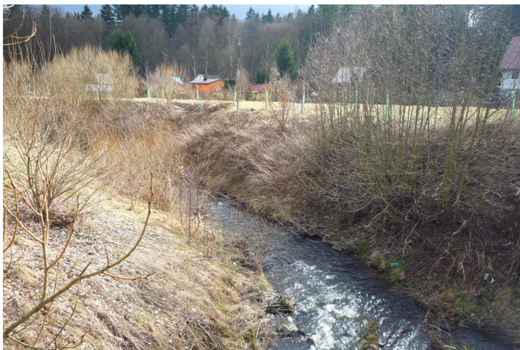
Obr. č. 8: Zobrazení svahu u mostu.
