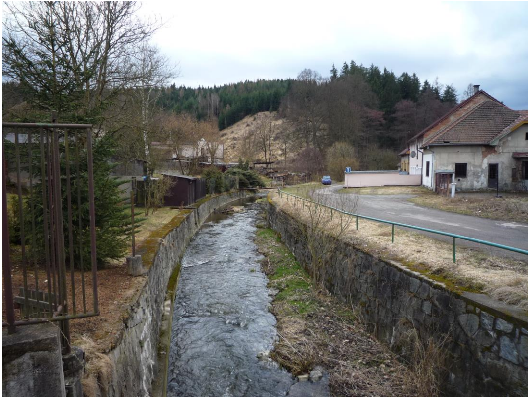
Obr. č. 38: Upravené koryto na území obce Senohraby.
