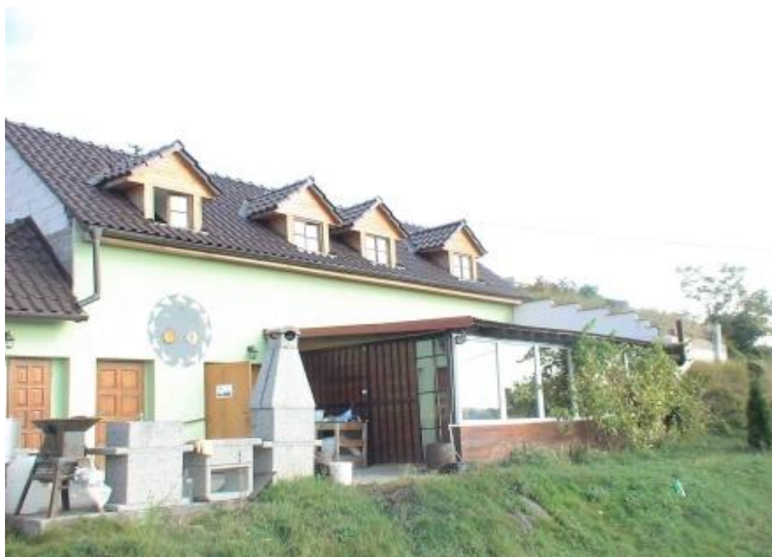
Fotografie 2: Vinařství Konárovice v roce 2008 - budova sklepa a penzionu ( foto archiv autora )
