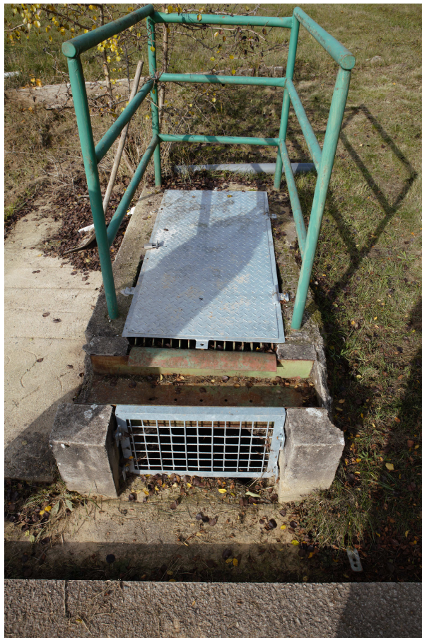
Obr. 2 Česle s uzamykatelným poklopem, KČOV Biskoupky
