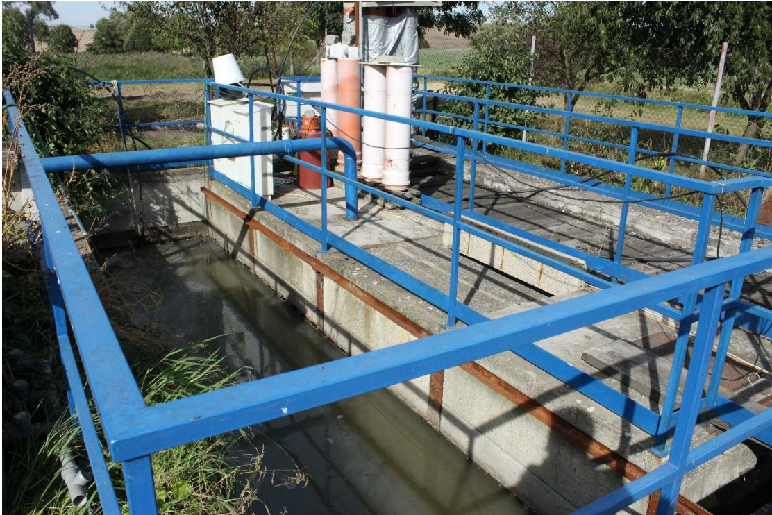
Obr. 5 Štěrbínová usazovací nádrž, KČOV Dražovice
