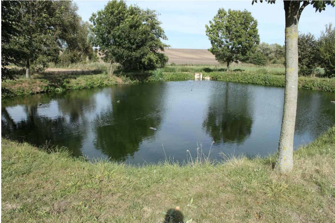
Obr. 9 Stabilizační nádrž, KČOV Dražovice (archiv ÚVHK)
