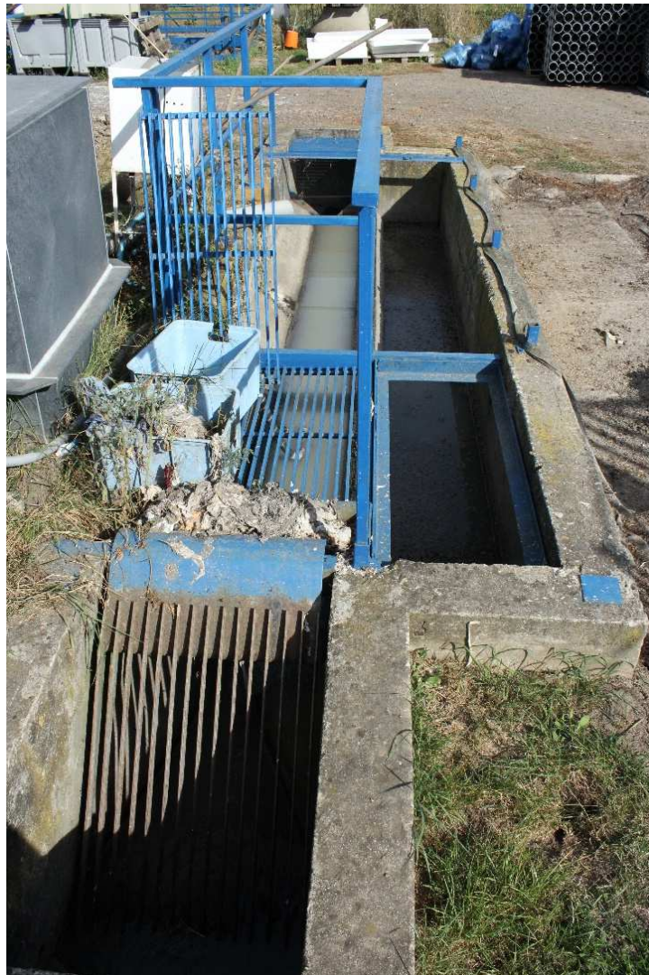
Obr. 3 Sdružený objekt – lapák písku a česle
