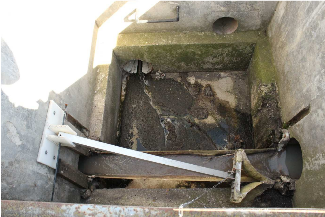
Obr. 1 Odlehčovací komora KČOV Dražovice
