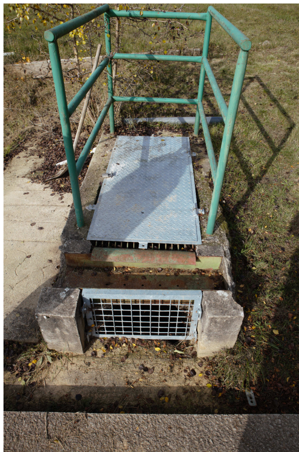
Obr. 2 Česle s uzamykatelným poklopem, KČOV Biskoupky
