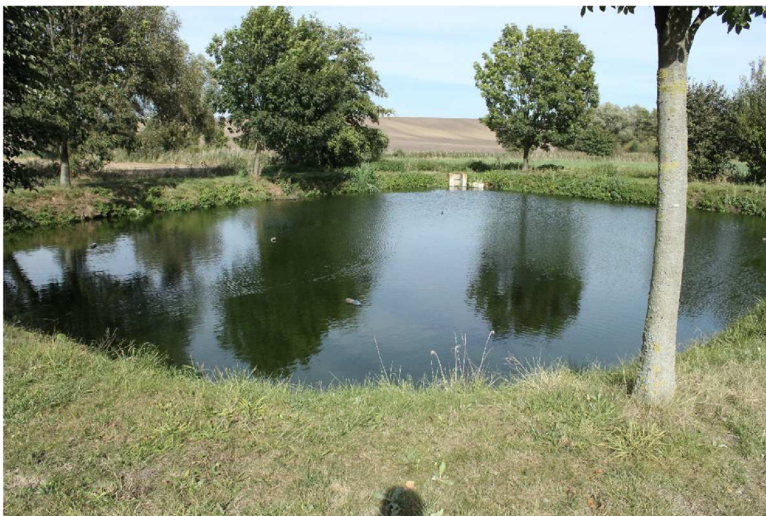
Obr. 9 Stabilizační nádrž, KČOV Dražovice (archiv ÚVHK)
