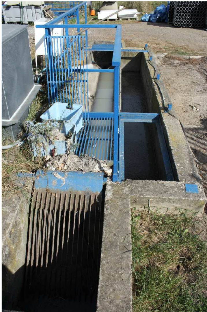
Obr. 3 Sdružený objekt – lapák písku a česle
