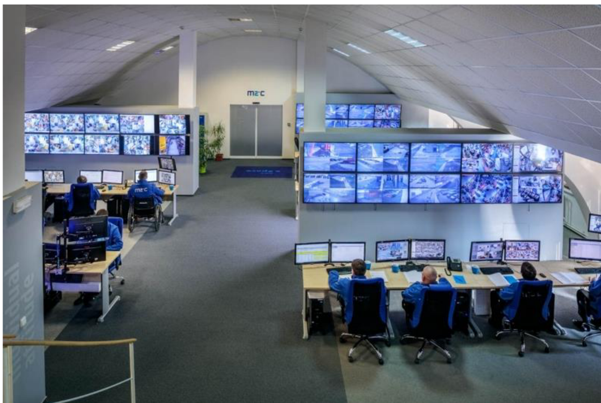
Obrázek 3 – Dohledové centrum společnosti M2C
