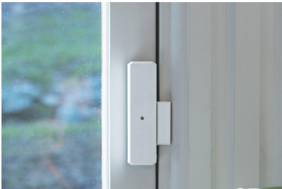
Obrázek 11 – Ukázka instalace magnetického kontaktu na okně
