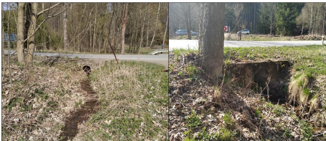
Obr. 27. KP25 – uzávěrový profil (vlevo), pohled směrem do povodí (vpravo)
