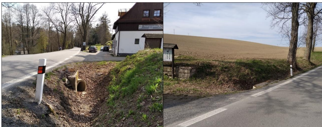
Obr. 20. KP4 – uzávěrový profil (vlevo), pohled směrem do povodí (vpravo)
