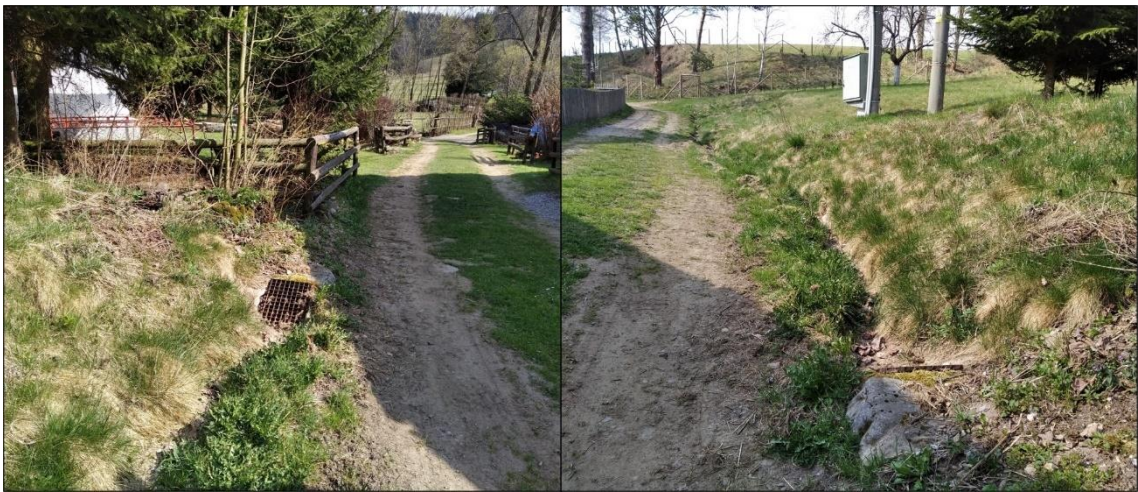
Obr. 25. KP18 – uzávěrový profil (vlevo), pohled směrem do povodí (vpravo)
