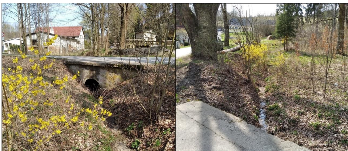
Obr. 29. KP31 – uzávěrový profil (vlevo), pohled směrem do povodí (vpravo)
