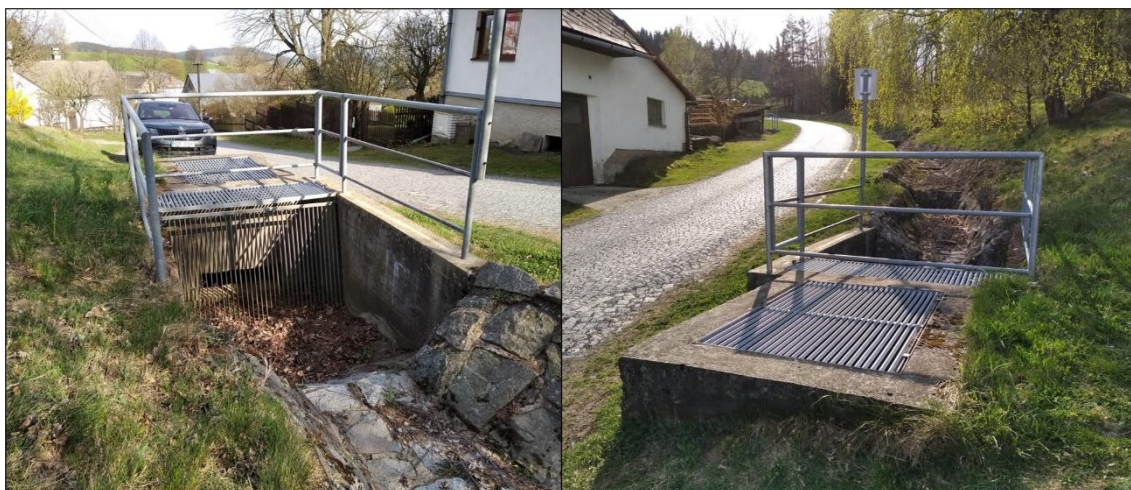
Obr. 22. KP16 – uzávěrový profil (vlevo), pohled směrem do povodí (vpravo)
