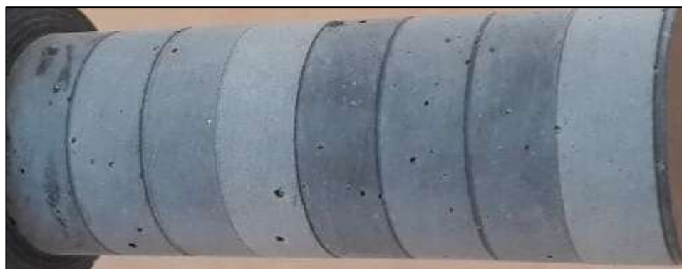
Obrázek 35: Vzduchové bubliny na povrchu obrobku
