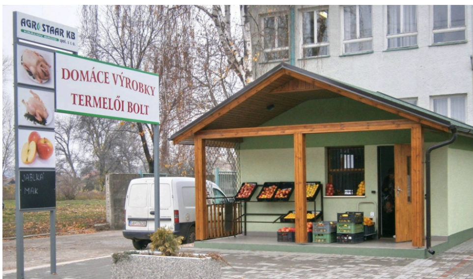
Obr. 19 - Predajný stánok pred administratívnou budovou spoločnosti
