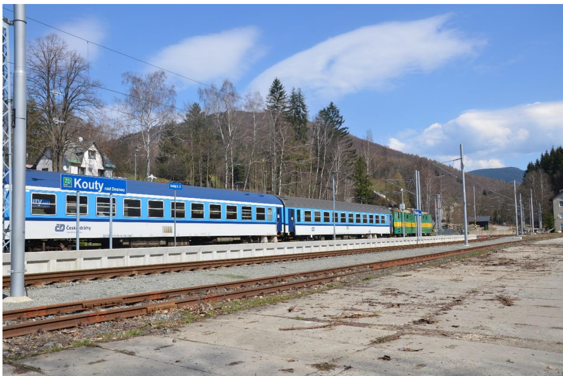
Obrázek 19: Elektrifikovaná železnice v Koutech nad Desnou.
