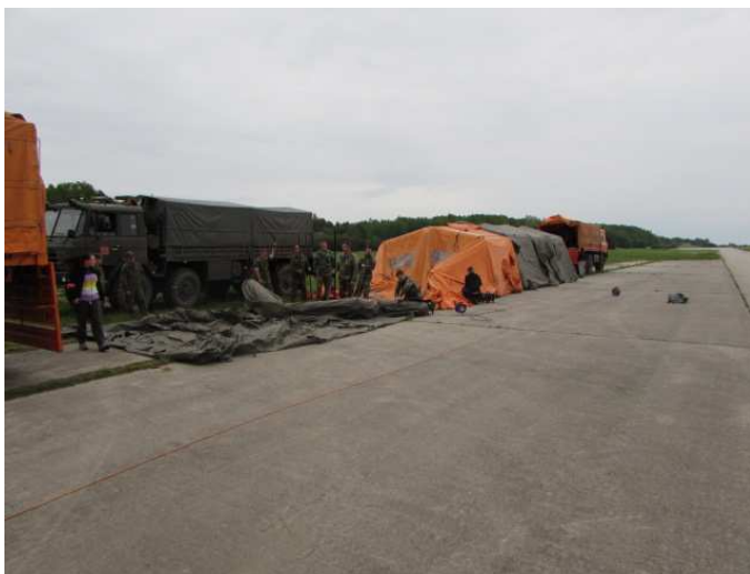
Obrázek 4: stavba stanoviště dekontaminace osob SDO, zdroj: vlastní
