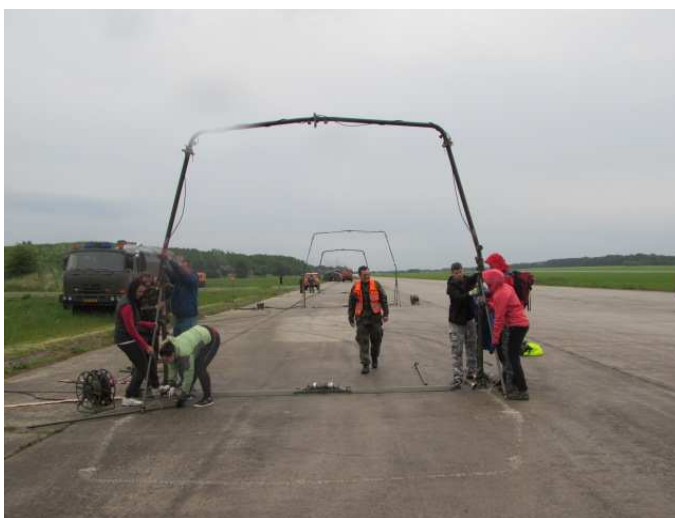
Obrázek 5: stavba dekontaminační linky pro techniku, zdroj: vlastní
